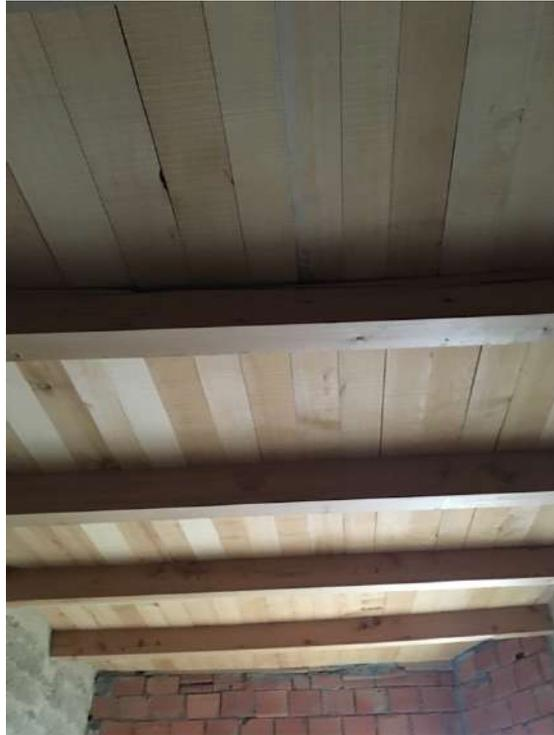
Photo 32 : Charpente en bois de cèdre d'une nouvelle construction
